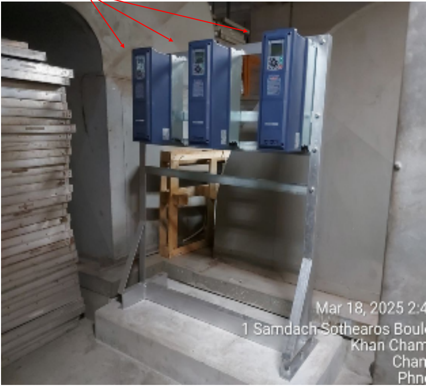
納品されたインバータ70台中の3台（外線未接続）
